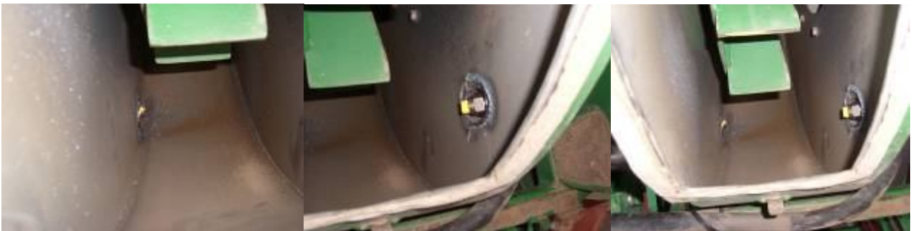
Fig.10: ugelli inseriti nel sul telaio del ventilatore di aspirazione
