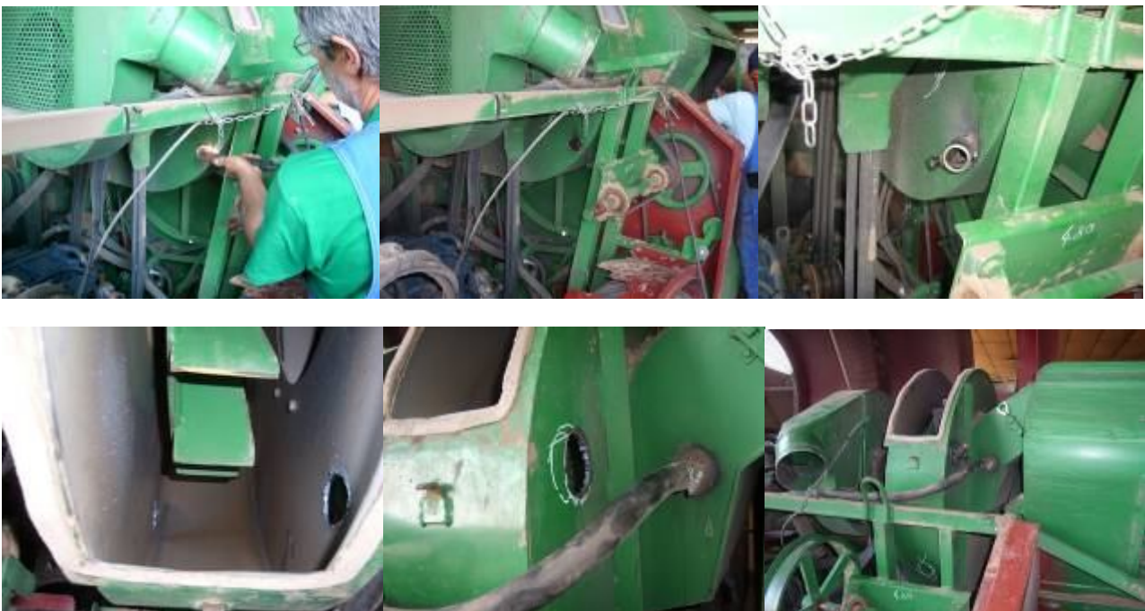
Fig. 8: realizzazione dei fori per il fissaggio degli ugelli
